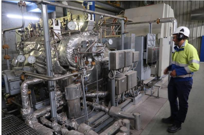
Le turbo alternateur, modernisé en 2016, transforme la vapeur en électricité pour 40 000 habitants. Photo Le DL/S.V.
